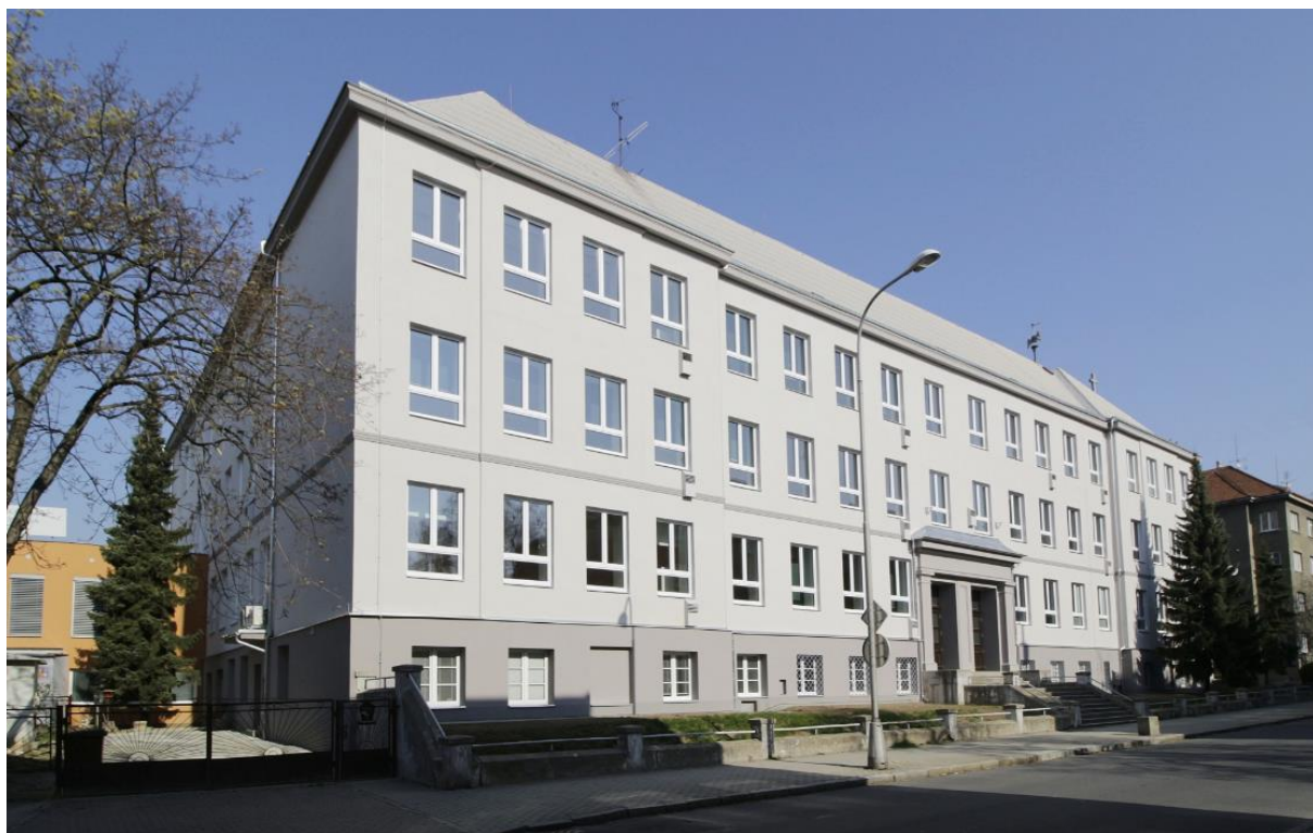
Hlavní budova školy po rekonstrukci
