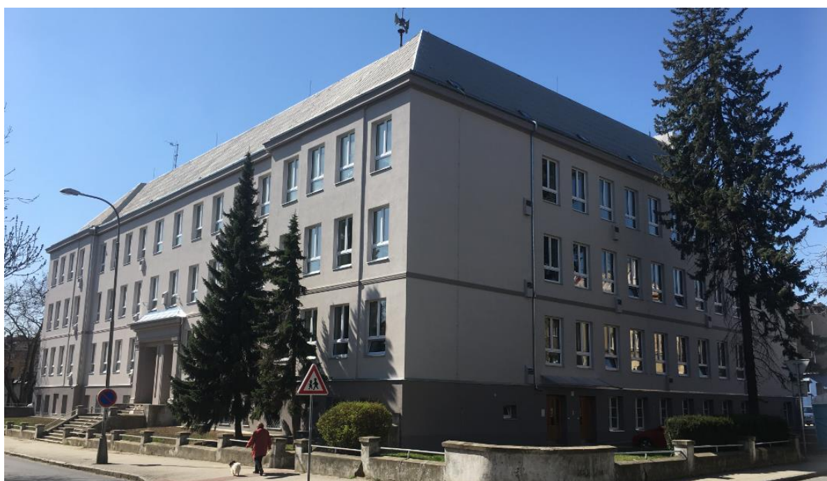
Rekonstrukce fasády budovy Hany Kvapilové 20
