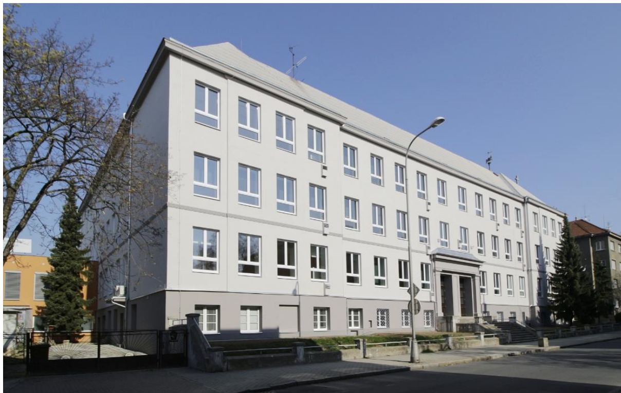
Hlavní budova školy po rekonstrukci
