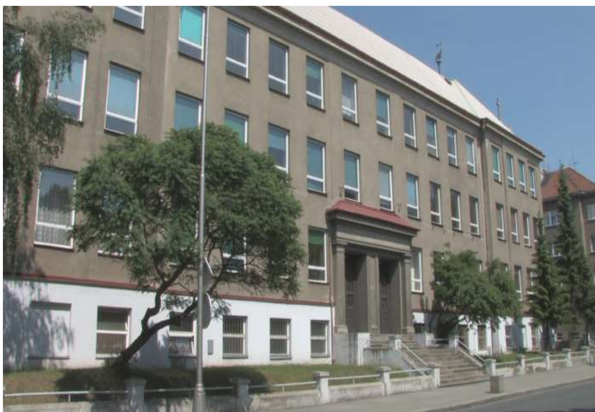
Stará budova školy
